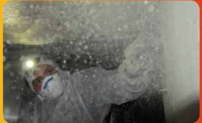
Ablagerungen im Lüftungskanal werden in Handarbeit von den Kanalwänden abgeschabt.
