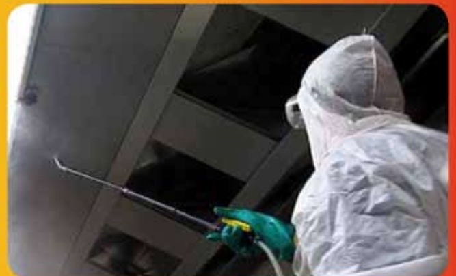
Vorbehandlung der verfetteten Oberfläche einer Ablufthaube mit fettlösender Reinigungschemie.
